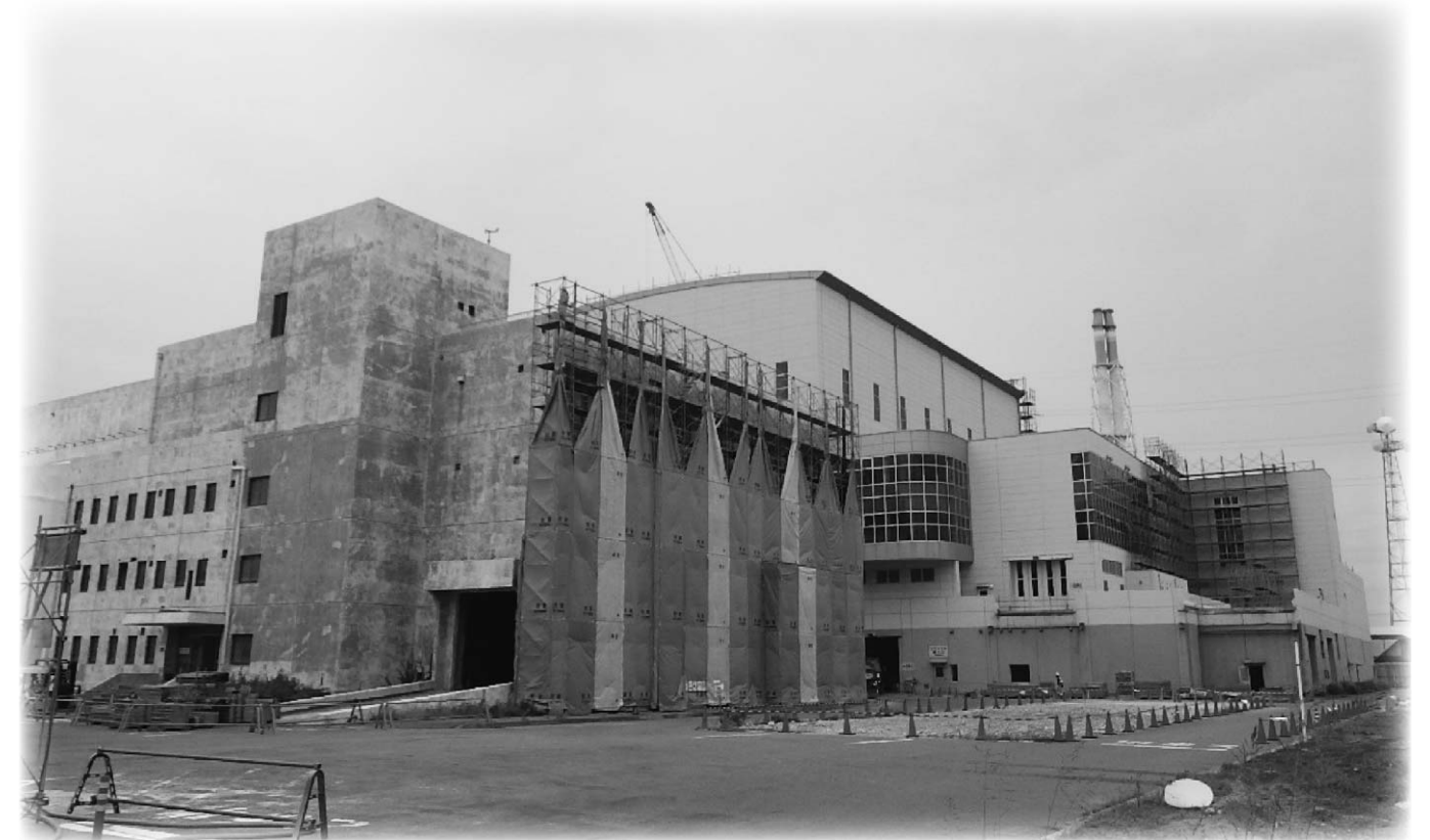
※現場全景(北西)
