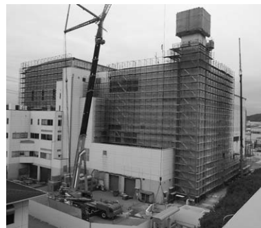
煙突解体 (10/12撮影)
