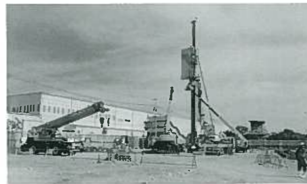
砂杭施工状況全景
