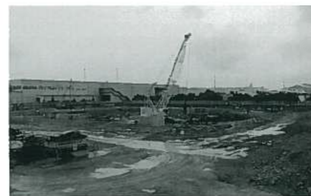
既設杭及び地中障害物の撤去工事状況(全景)
