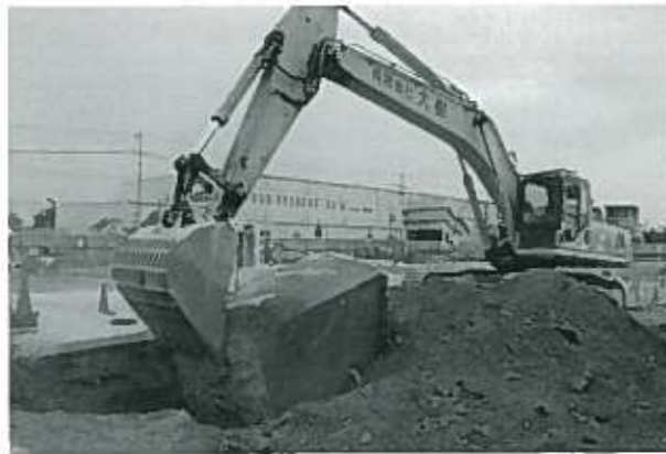
地下部基礎解体作業
