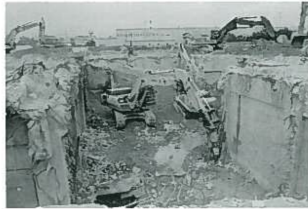
地下部基礎解体作業
