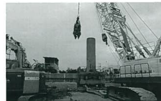
既設杭及び地中障害物の撤去工事状況
