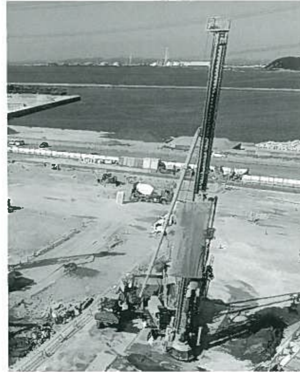
砂杭施工状況
