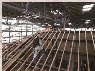
工楽松右衛門旧宅 屋根工事中
