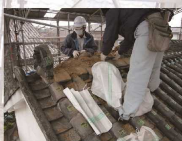
旧入江家住宅表屋 屋根工事中
