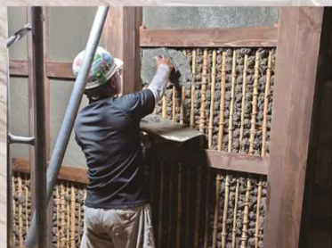
旧入江家住宅蔵 左官工事中
