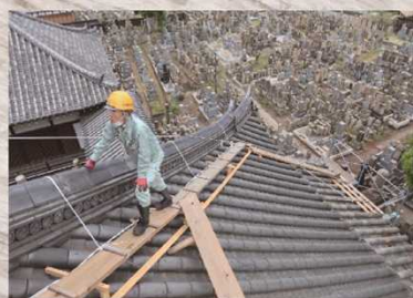
十輪寺本堂 防災工事中
