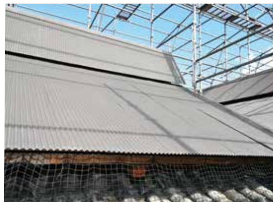
屋根瓦の破損への応急措置として付けられた鉄板も 今しか見られない光景です
