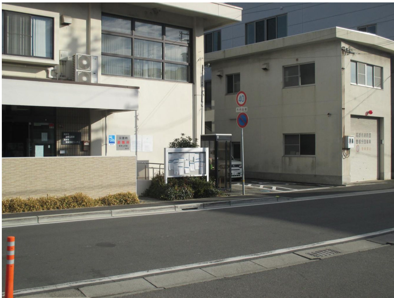
【曾根公民館跡・曾根分団車庫跡及び水防倉庫跡近景】
