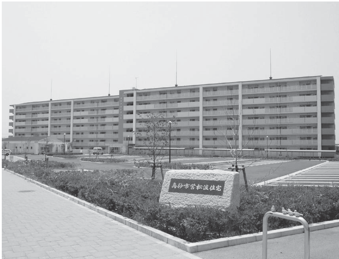
▲市営松波住宅
