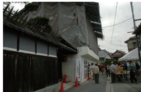
【旧入江家住宅の修理現場見学会】
