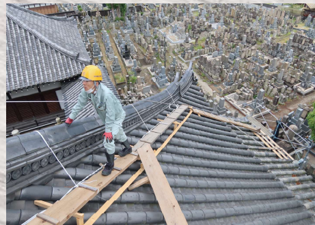
十輪寺本堂 防災工事中
