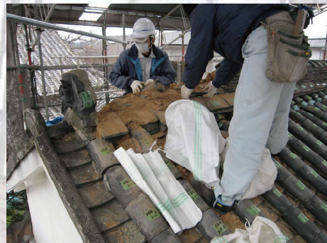
旧入江家住宅表屋 屋根工事中
