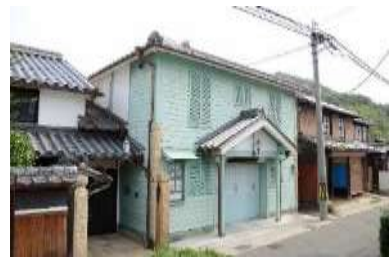
国登：土田家住宅旧魚橋郵便局舎
