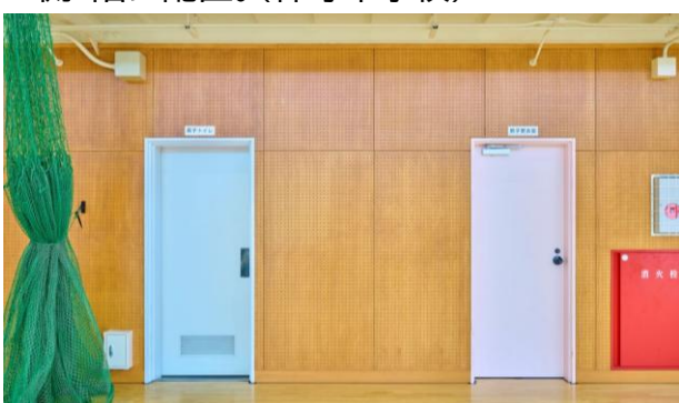
男女それぞれの更衣室とトイレを設置した。(蛭間小学校)
