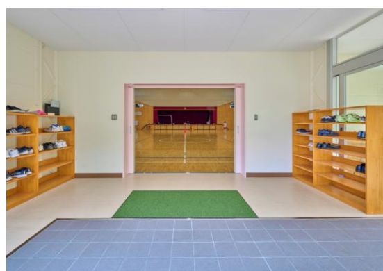
スロープと組み合わせた、エントランス部分のバリアフリー化(神守中学校)
