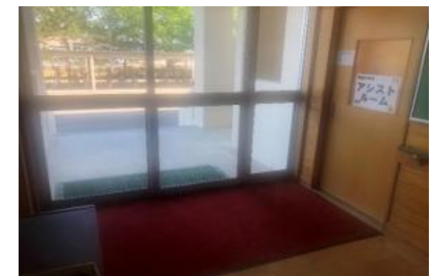
非常口のそばに設置されている
