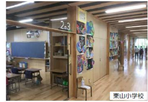
写真-4【可動間仕切りの教室】 東山小学校
