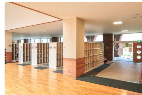
誰でも使いやすい、段差のない昇降口
