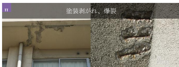
松陽中学校_南棟
