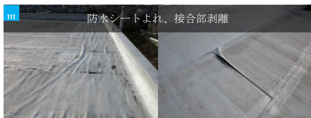
米田小学校_西棟
