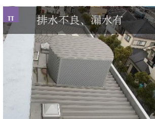
中筋小学校_給食室棟
