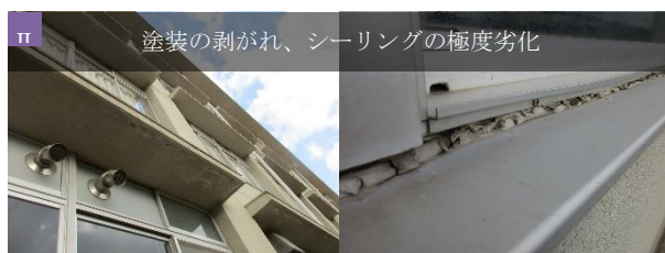
米田西小学校_南棟
