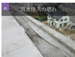
伊保小学校_西棟
