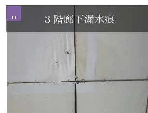
松陽中学校_南棟
