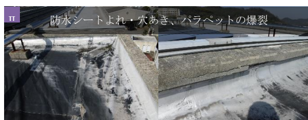
北浜小学校_北棟東
