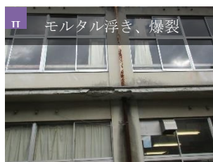
宝殿中学校_北棟西
