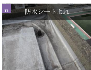
米田西小学校_北棟
