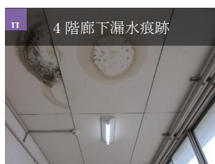
荒井中学校_昇降口棟
