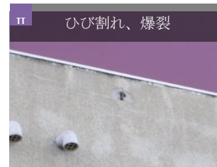
北浜小学校_北棟東
