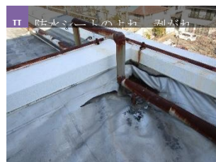
宝殿中学校_北棟西
