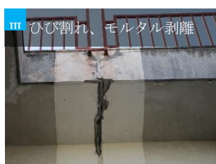
中筋小学校_北棟
