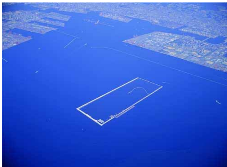
図 4.3.2-1 大阪湾広域臨海環境整備センター 神戸沖埋め立て処分場
