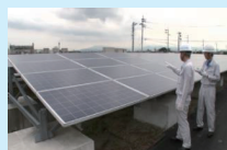
太陽光発電設備の検査の様子
