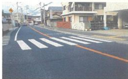
①国道250号(天川橋東側)
