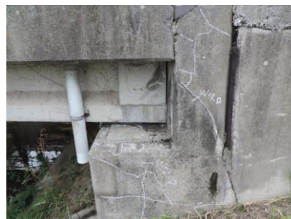
下部工にひびわれが見られます（区分Ⅲ）
