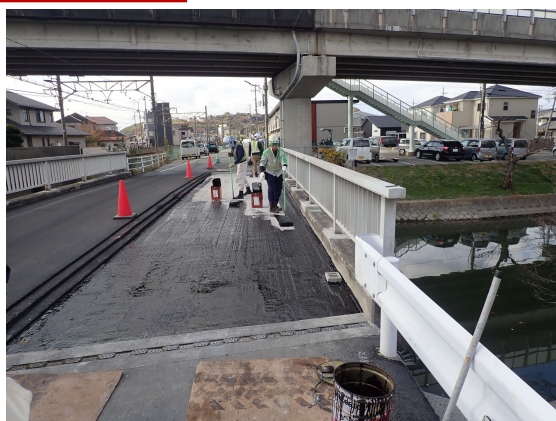
曽根 34 号橋 橋面防水工 R2 年度補修完了
