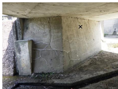
下部工にひびわれが見られます (区分Ⅱ)
