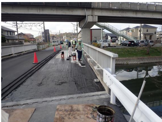
曾根 34 号橋 橋面防水工 R2 年度補修完了
