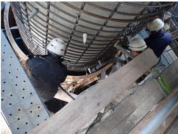
高砂大橋 R4 年度 RC 巻立て補強工 施工中及び完了後
