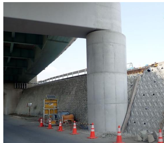
高砂大橋 R4 年度 RC 巻立て補強工 施工中及び完了後
