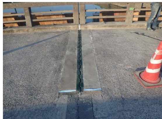
天川橋 伸縮装置取替工 R4 年度補修完了
