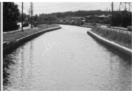
松村川河川改修
