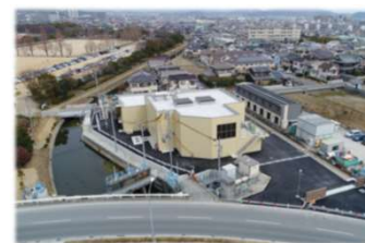
間の川ポンプ場
