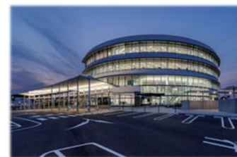
高砂市役所新庁舎
