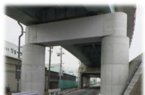
橋梁の耐震化（高砂大橋）
