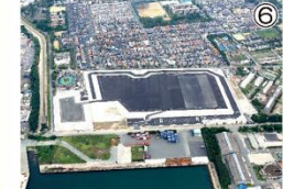
高砂西港整備後の写真
