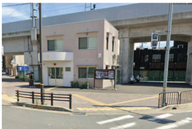
鉄道高架化に合わせて整備した交番
