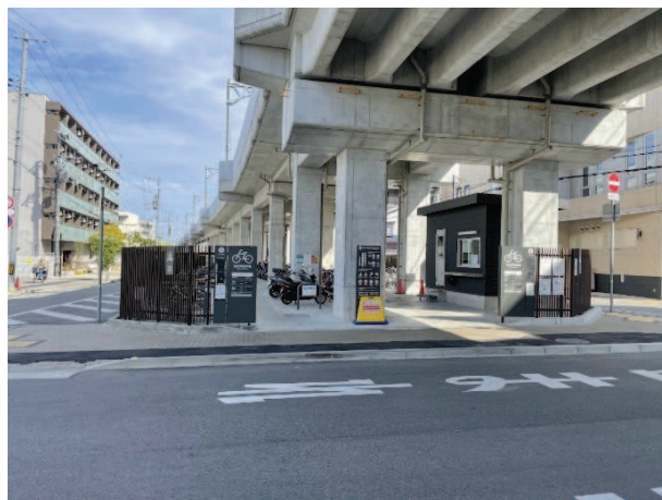
高架下の駐輪場
