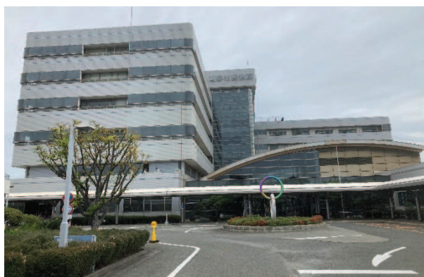
老朽化が進む高砂市民病院
