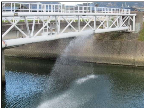
令和3年度：高砂市（第2天川橋水管橋）
