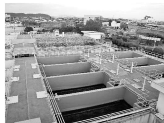
老朽化した浄水施設 (米田水源地)
