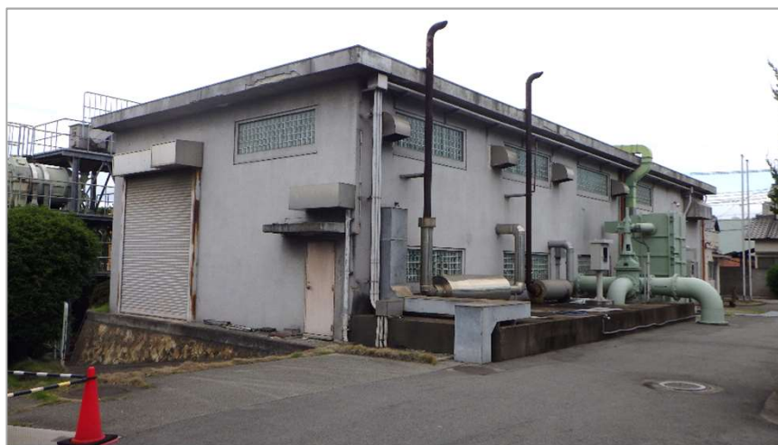
高砂浄化センター合流ポンプ室(外観)
