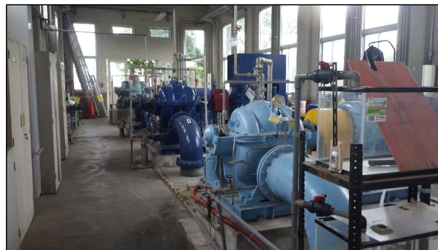
米新ポンプ場(内部)
