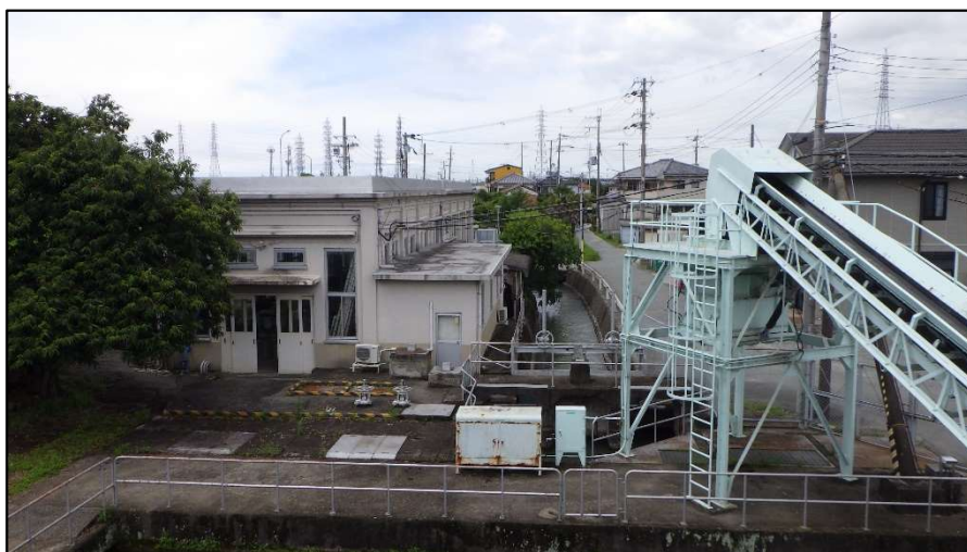
米新ポンプ場(外観)
