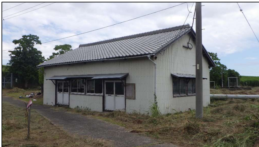
古新水源地 建物(外観)
