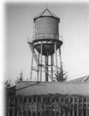
旧朝日町浄水場 配水塔(完成)
