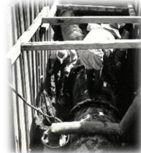
水道管布設状況
