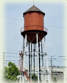
旧朝日町浄水場配水塔(令和5年)
