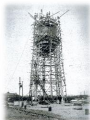
旧朝日町浄水場 配水塔(建設中)
