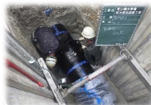
水道管(耐震管)布設状況
