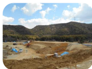
(大池改修工事)
