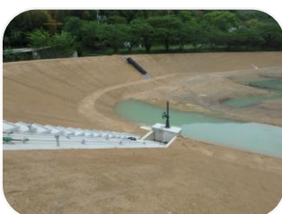
(大池改修工事)
