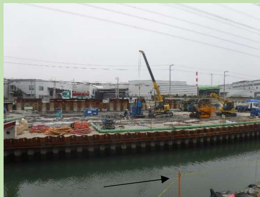
川底の地盤改良工事の様子(撮影:令和2年4月17日)
