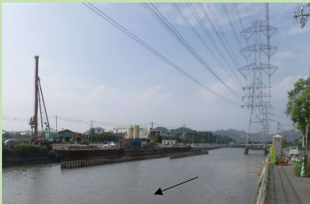
梅雨や台風に合わせて川の中での工事は休止中
