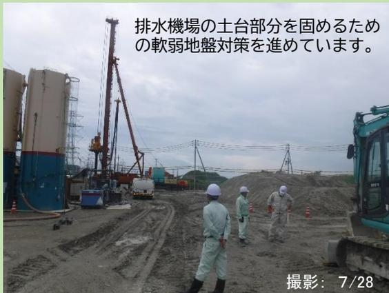
排水機場の土台部分を固めるための軟弱地盤対策を進めています。
