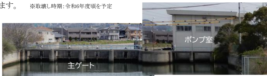
乗切橋から望む 鹿島排水機場
