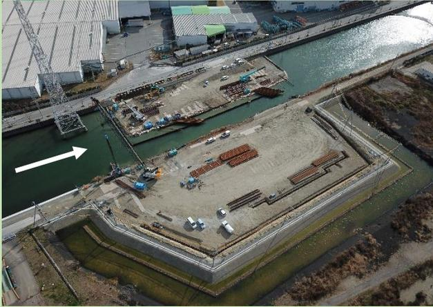
仮設工(鋼矢板打設)
