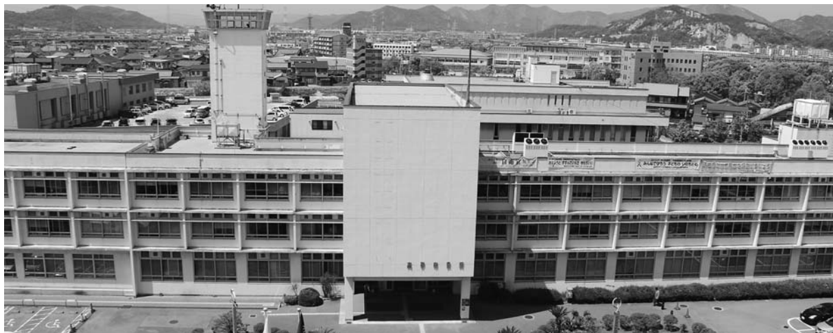
高砂市役所本庁舎
