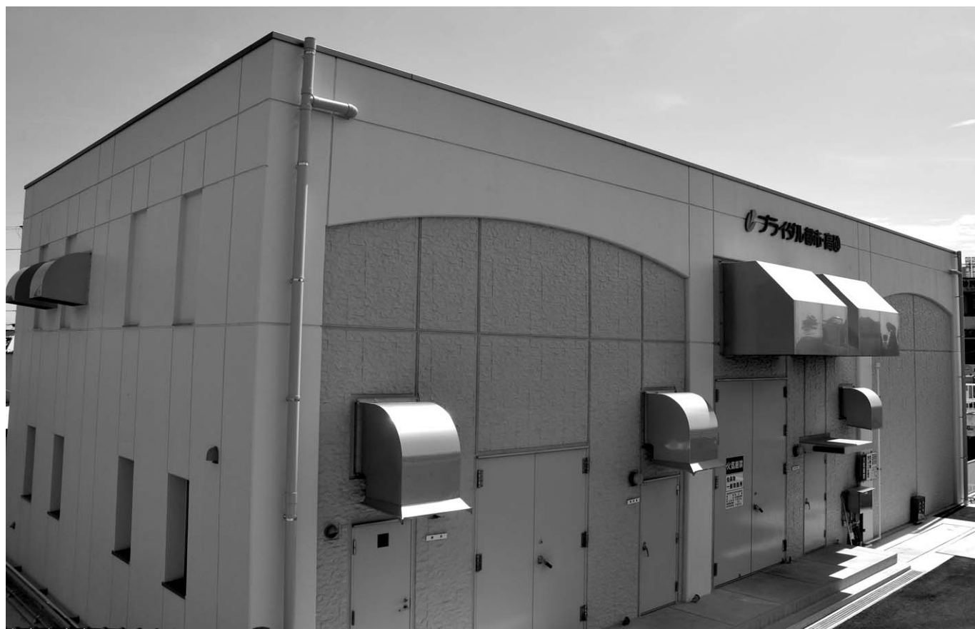
7月11日に竣工式が行われた中島ポンプ場
