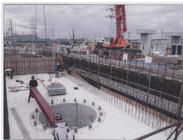
写真 6（工事記録写真より）
