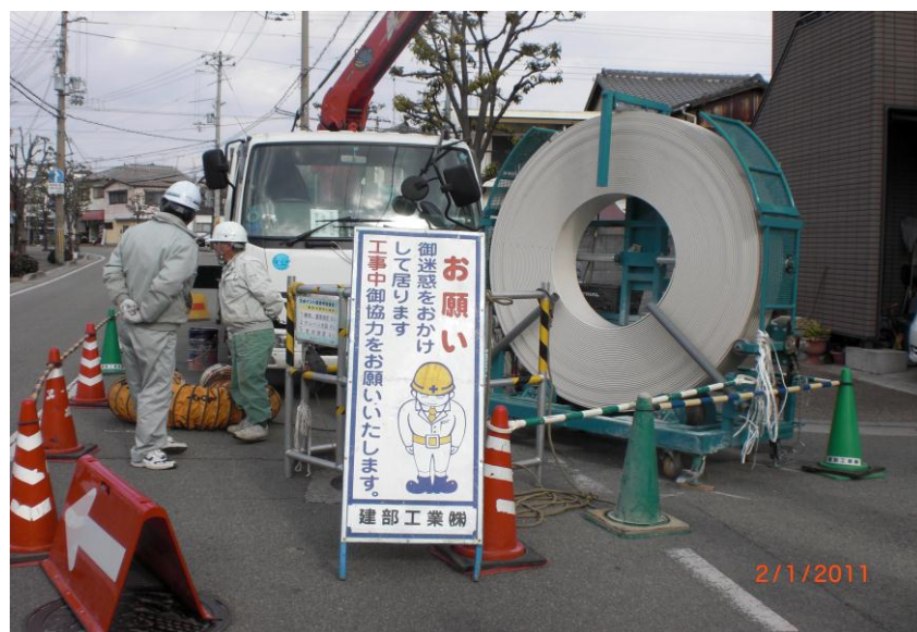
【第2工区のNO. 1のマンホール付近の施工状況】
