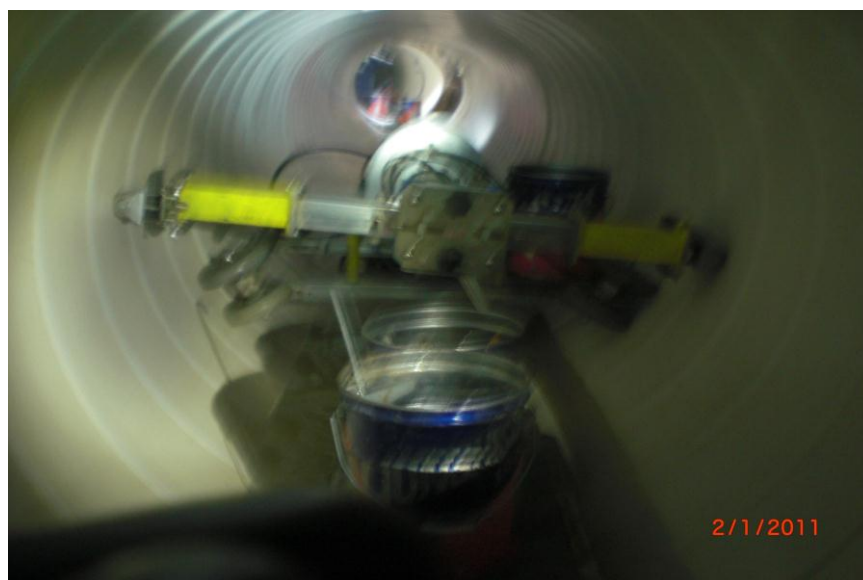
【第2工区の1～2の坑内の製管状況】
