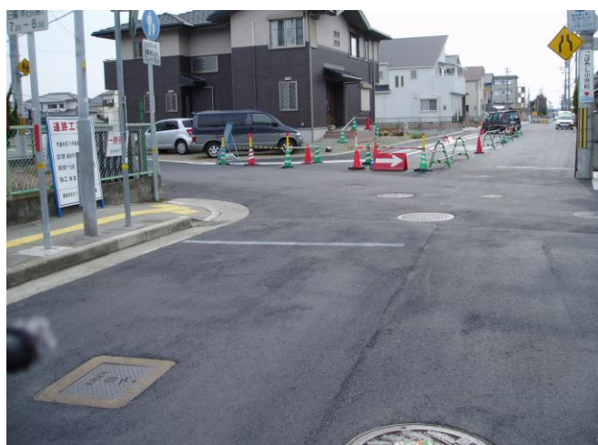
測点 NO.3 付近の施工状況
