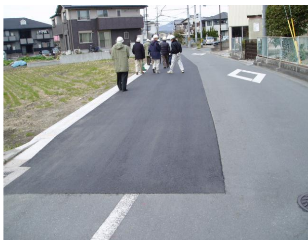
測点 NO.0～NO.3 の施工状況
