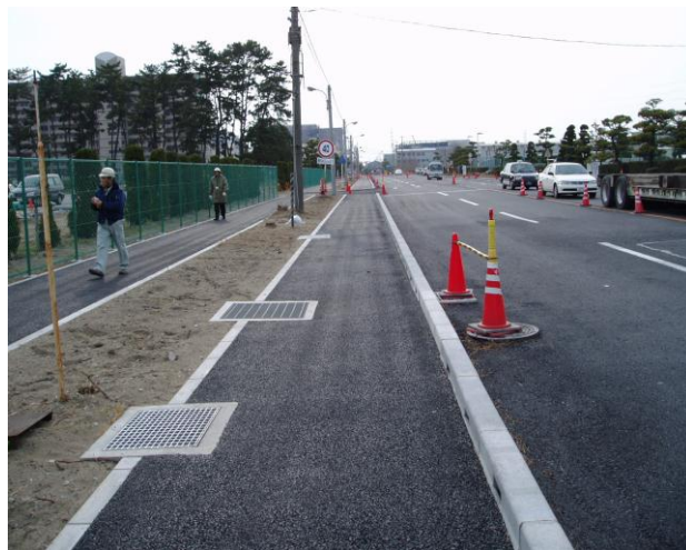
測点 NO.3 付近の歩道部
