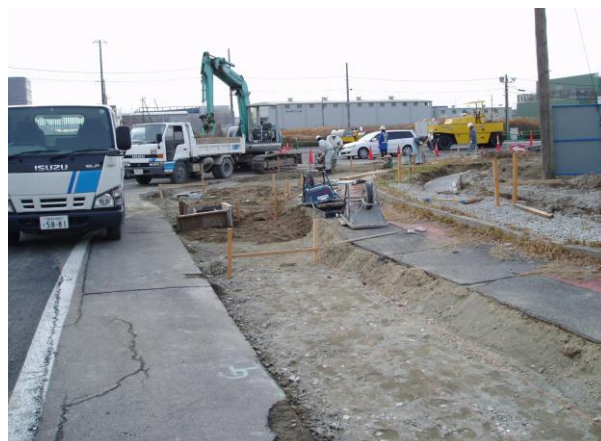
測点 NO.1 1 付近の神鋼側の歩道部施工中
