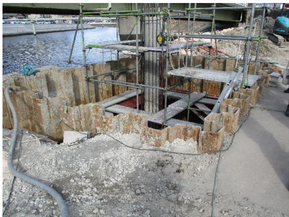
P1橋脚施工状況 (転落防止柵の設置が必要)
