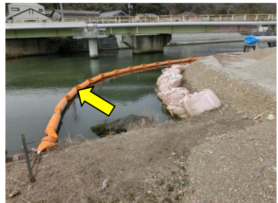
汚濁防止フェンスの設置（河川内）
