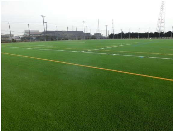
フィールド（人工芝舗装工）
