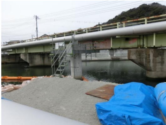
水管橋（架設済み）
