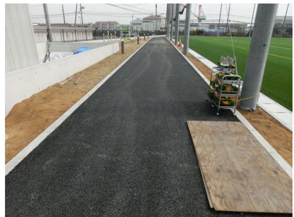
ランニングコース（ゴムチップ舗装工：基層）
