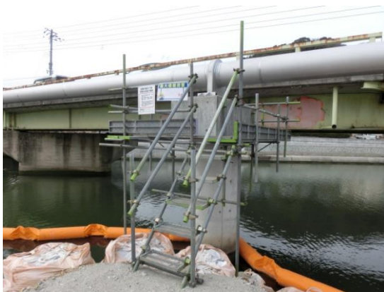
水管橋（中間支点部）
