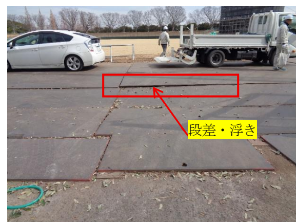
敷鉄板状況(段差状況)
