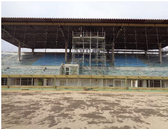
バックスタンド施工状況
