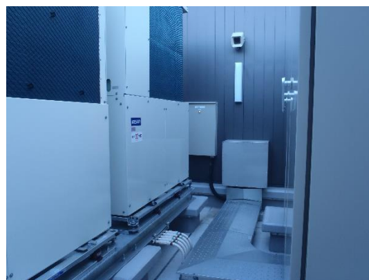
2階 屋上室外機 置場
