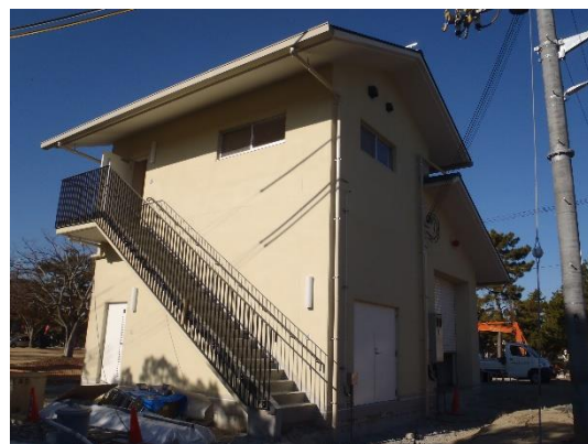
分団庫 外部 南東面
