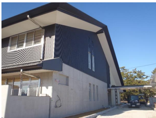
交流・子育て支援センター 外部 南東面
