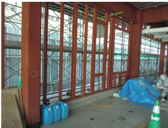
1階外壁下地鉄骨
