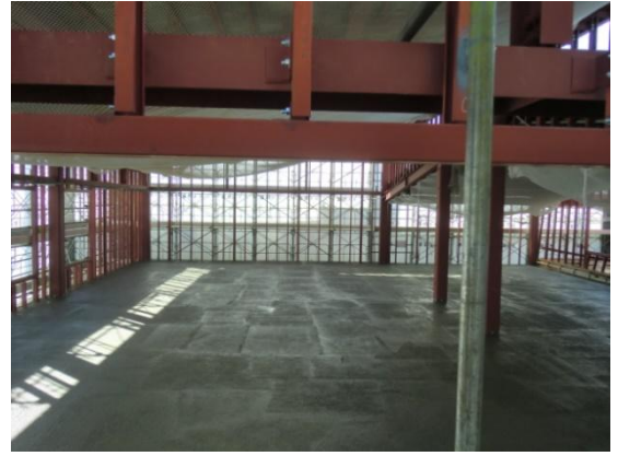
2階デッキコンクリート打設
