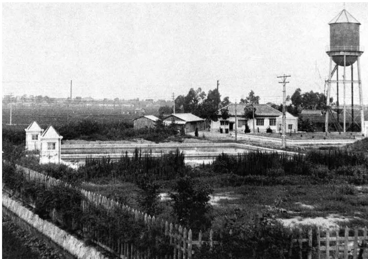
・朝日町浄水場
