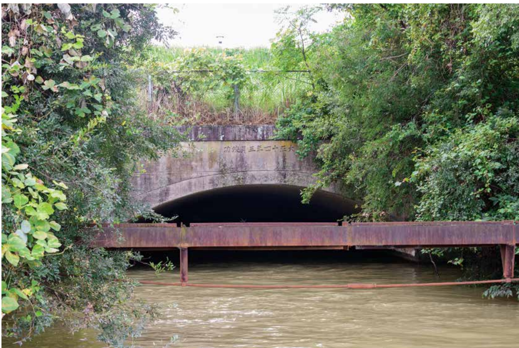
・堤内水路より洗川樋門を望む
