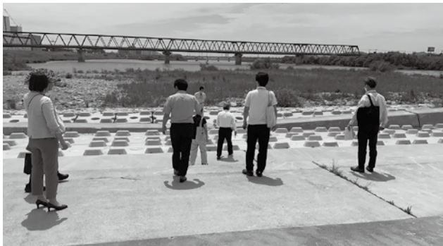
加古川堰堤仮復旧状況の確認
