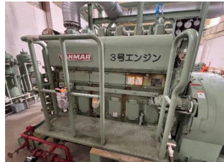
荒井ポンプ場
