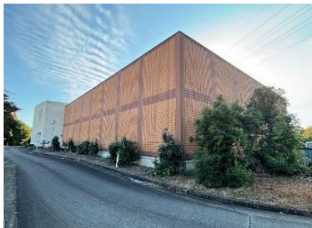
天川第2ポンプ場
